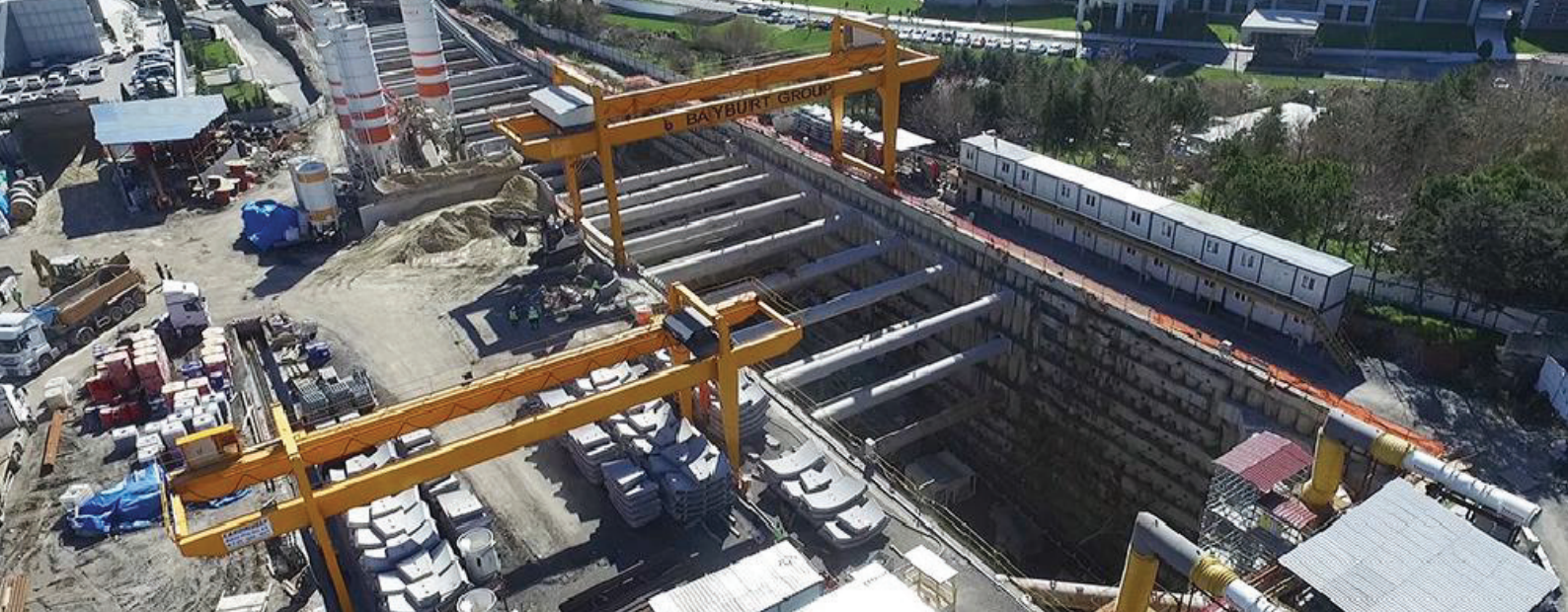
Строительный объект в районе Собанчесме (Чобанчешме). Изображение предоставлено Городским муниципалитетом Стамбула.
